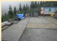
作業道が一番下の退避所は、大型車両（特に生コン車）等の往来が頻繁に行われるので、路盤補強も考慮し、軟弱土は全て撤去し再生ランで入れ替えた。
